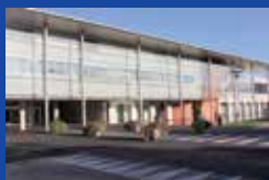
Hôpital Schweitzer 201 Avenue d'Alsace
